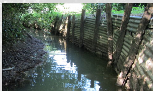
Protection de berge en tôle
