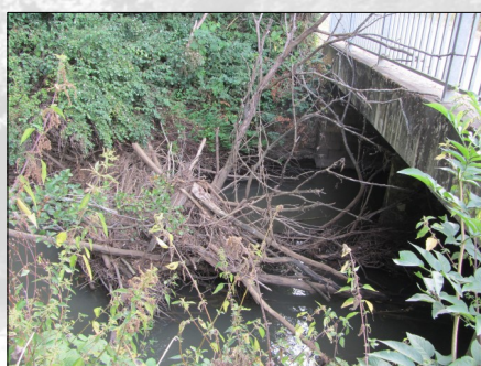
Embâcle en amont d'un pont, obstruant les écoulements
