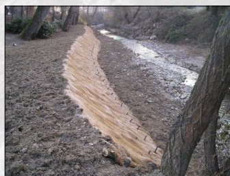
Géotextile et boutures
