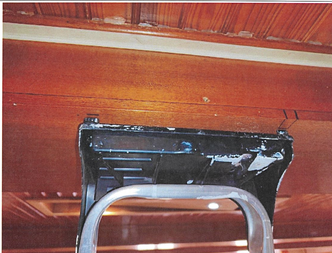
C- Marquage de cette position au niveau du coffrage pour s'assurer d'une éventuelle évolution dans le futur.
