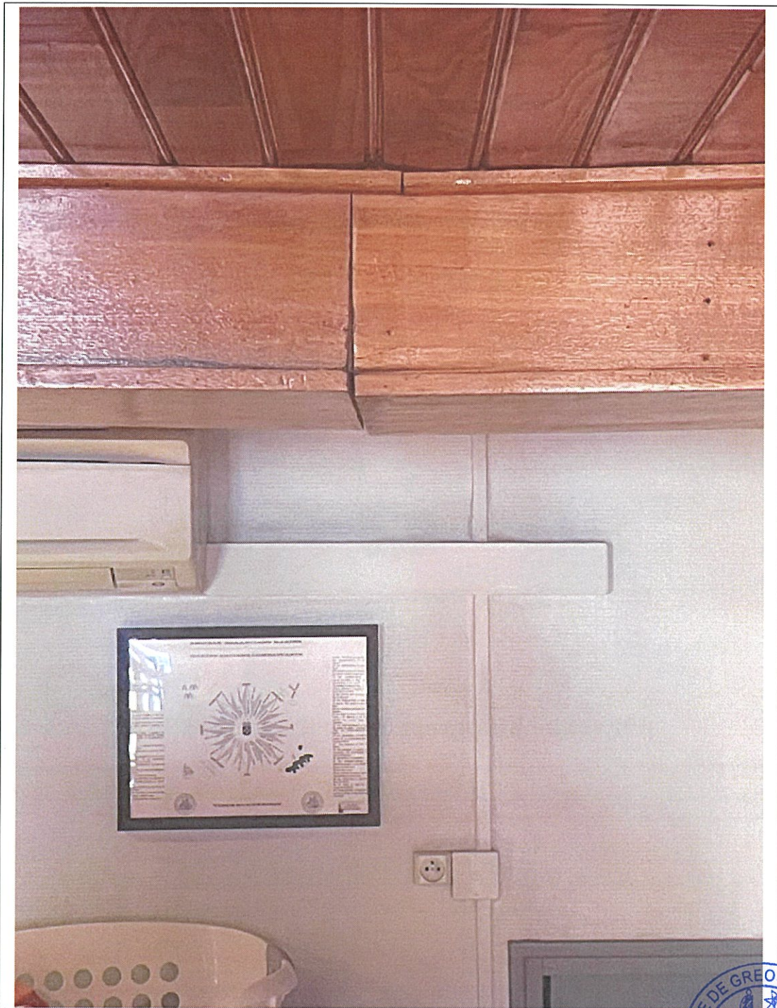
A - Vue du coffrage de la poutre de la salle de restaurant.
